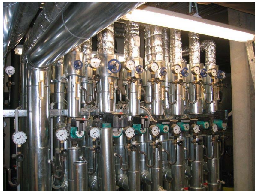
Verteiler in der Zentrale
