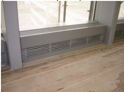
Konvektor in Nischenverkleidung
