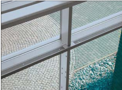
Fassadenheizsystem (Quelle: Fa. Kampmann)
