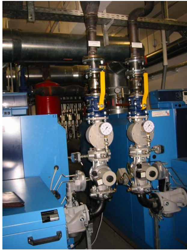
Gasheizkessel mit Gas-Regelstrecke und Schalldämmhauben
